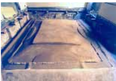
26 e 27. Sala del Disegno estradosso della volta prima e dopo il consolidamento e la successiva intonacatura con malta pozzolanica
