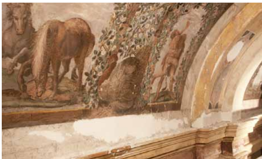
91. Corridoio di Ercole stuccatura delle lacune di intonaco
