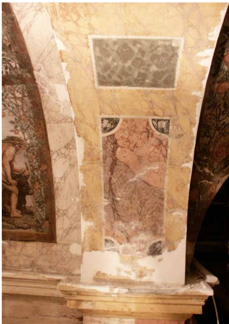
89, 90. Corridoio di Ercole stuccatura delle lacune di intonaco
