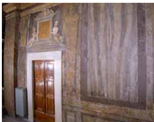
16. Corridoio di Ercole decorazione con tecnica a secco
